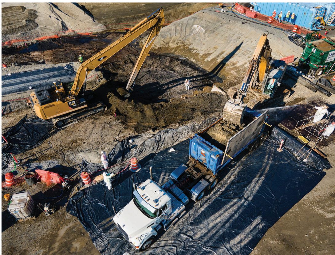
La excavadora a la derecha carga el último cubo de tierra afectada por cromo de los terrenos ubicados al sur de la avenida Carteret.
